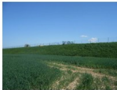
Figure 2 : Digue des bassins de décantation surplombant le site de la ZAC
